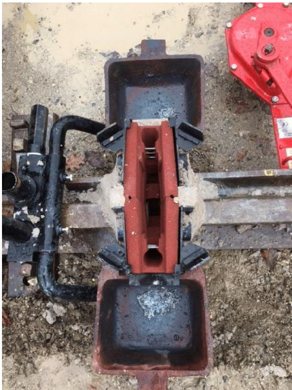
Foto tv.: Formen, hvor man kan se sprækken ned til skinneenderne, og rillen er pakket tæt, så der ikke løber noget ud i rillen. Der er kun 1 "skud", så det kræver professionelle folk! Foto taget af Gunnar Larsen.
