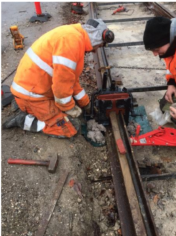
Foto th.: Form og selv opstilling. Alt skal være "pakket", inden der forvarmes og senere det flydende jern. Foto taget af Gunnar Larsen.
