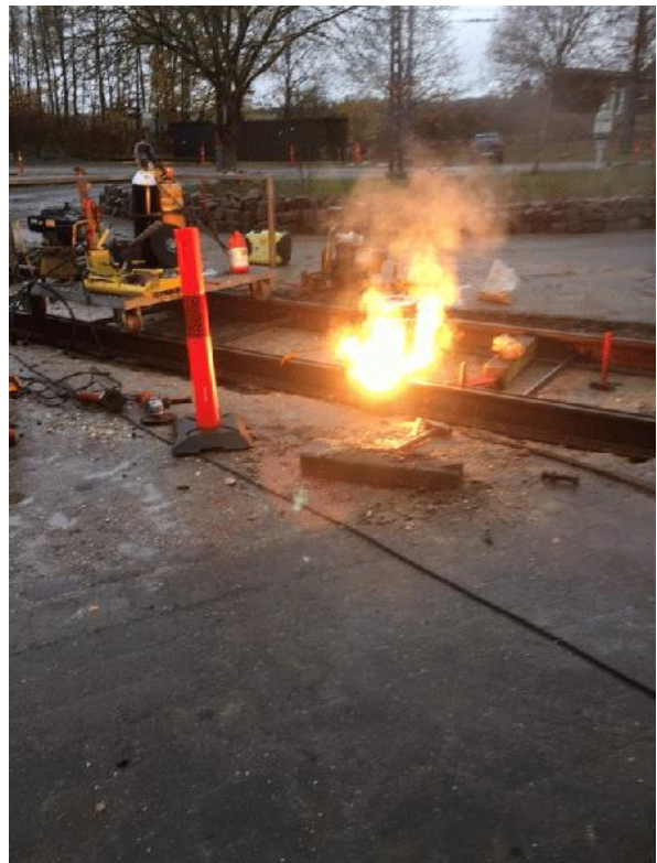
Foto tv.: Formen, hvor man kan se sprækken ned til skinneenderne, og rillen er pakket tæt, så der ikke løber noget ud i rillen. Der er kun 1 "skud", så det kræver professionelle folk! Foto taget af Gunnar Larsen.
