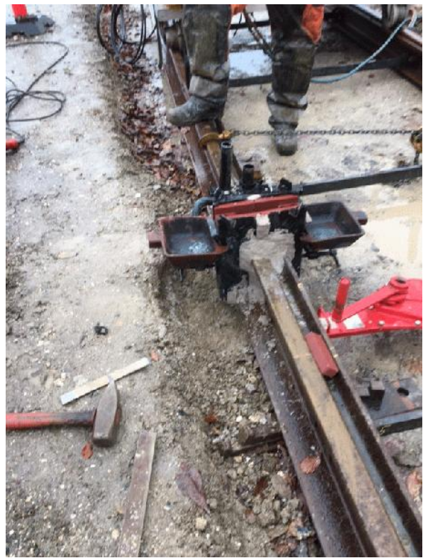
Foto th.: Form og selv opstilling. Alt skal være "pakket", inden der forvarmes og senere det flydende jern. Foto taget af Gunnar Larsen.
